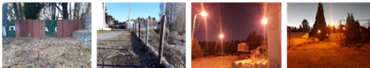
Cerco Este reparado
