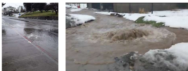
Imágenes: ingreso de pluviales a las redes cloacales
