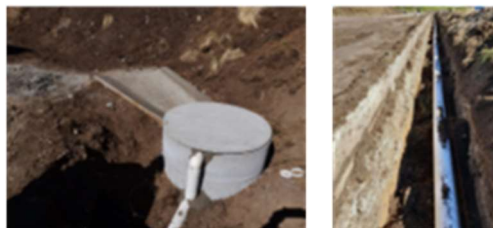
Imágenes: obras varias en planta de compostado
