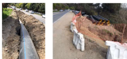
Imágenes: obra refuncionalización Avda. Bustillo
