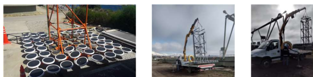
Imágenes: sistema de aireación
